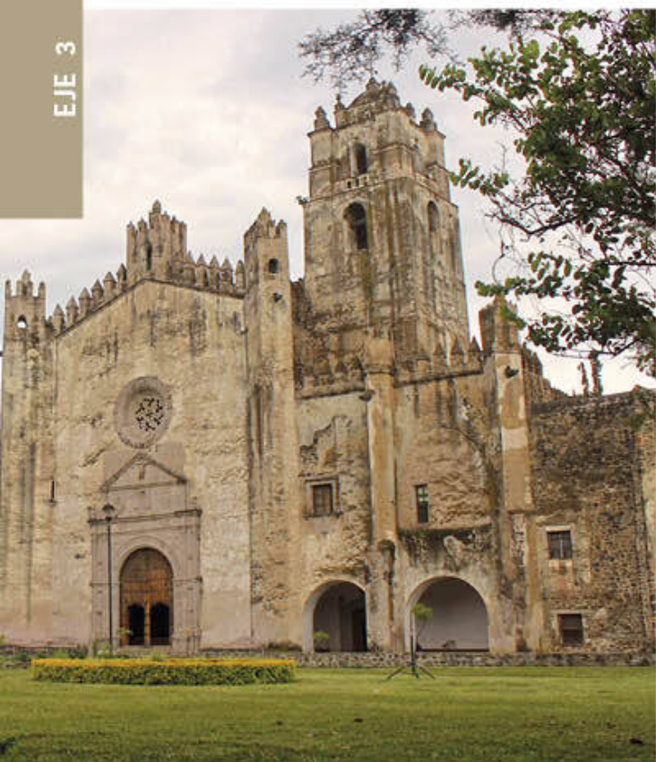
▲ Figura 3.54. El convento de Yecapixtla, Morelos, muestra las características de la arquitectura conventual del siglo XVI (Fotografía de JLB).
