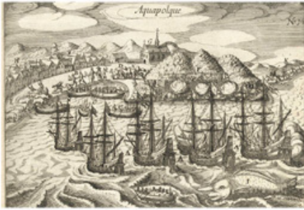
▲ Figura 3.43. El puerto de Acapulco, principal enlace del imperio español con sus posesiones de Oriente (FUENTE: Grabado de Spilbergen, 1616).
